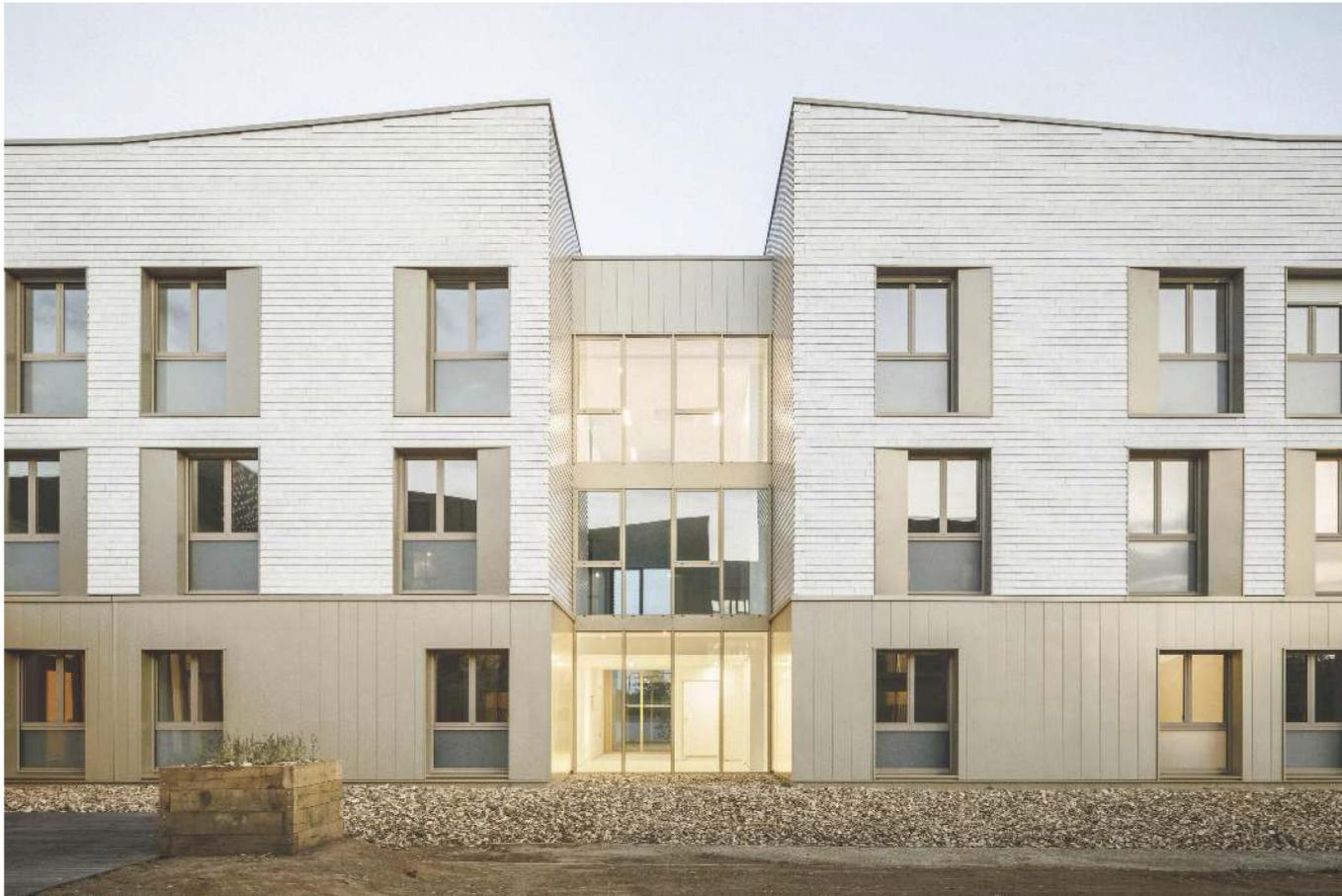
Façade sur cour des logements étudiants. Les descentes d'eaux pluviales rejoignent les gaines des logements et disparaissent de la façade.
